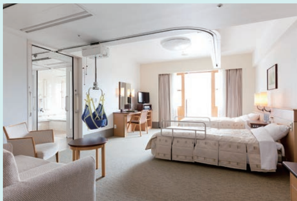
部分房间还配备天花板提升移送系统
